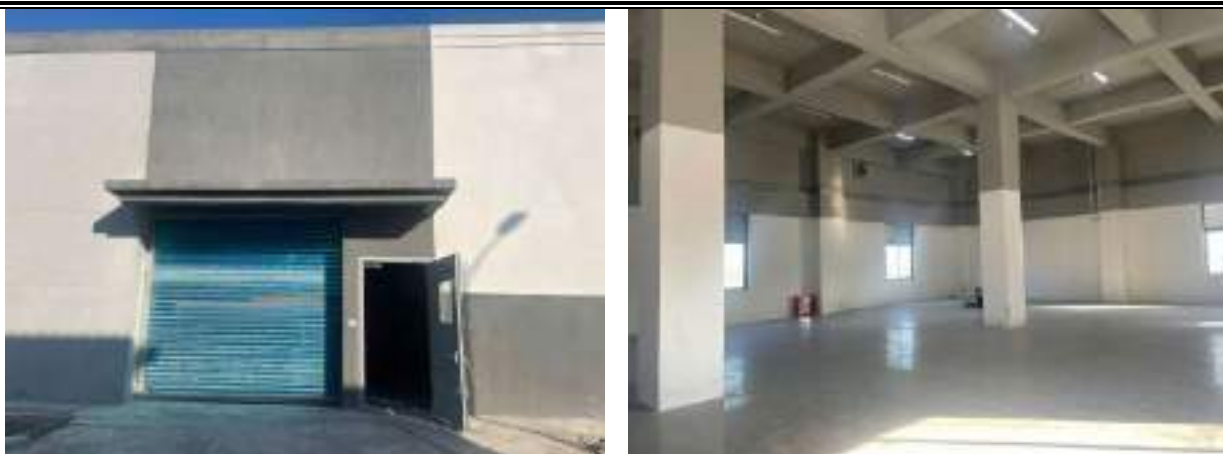
Hình 3. 13. Kho chứa CTR công nghiệp thông thường
