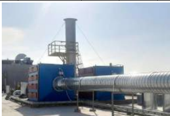
Hình 3. 8. Hệ thống XLKT đã lắp đặt tại dự án
