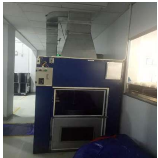
Hệ thống chụp hút và đường dẫn khí thải dây chuyền sản xuất và hàn băng mạch (SMT)
