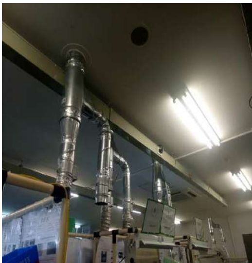
Chụp hút, ống dẫn khí thải dây chuyền lắp ráp điện, điện tử và đồ gia dụng khác.
