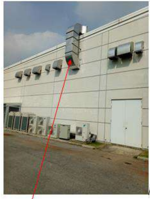
Ống khói khí thải dây chuyền sản xuất và hàn bảng mạch (DIP)
