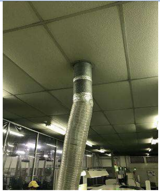
Hệ thống chụp hút và đường dẫn khí thải dây chuyền sản xuất và hàn băng mạch (SMT)
