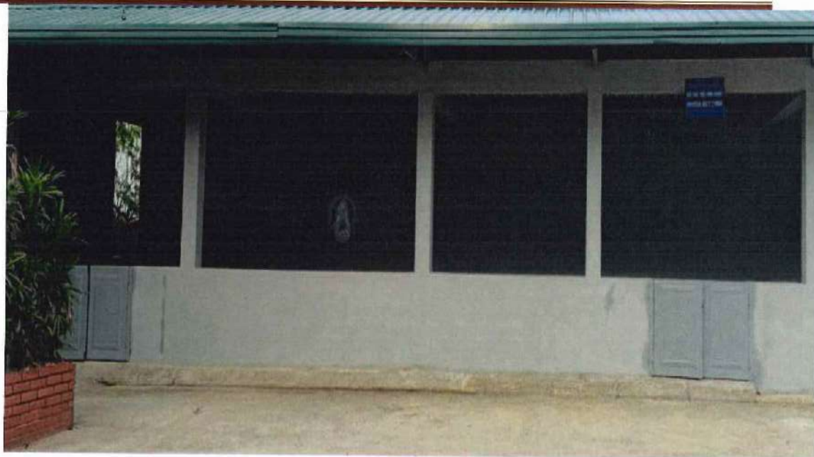
Hình 15 Hình ảnh kho chứa rác thải công nghiệp
