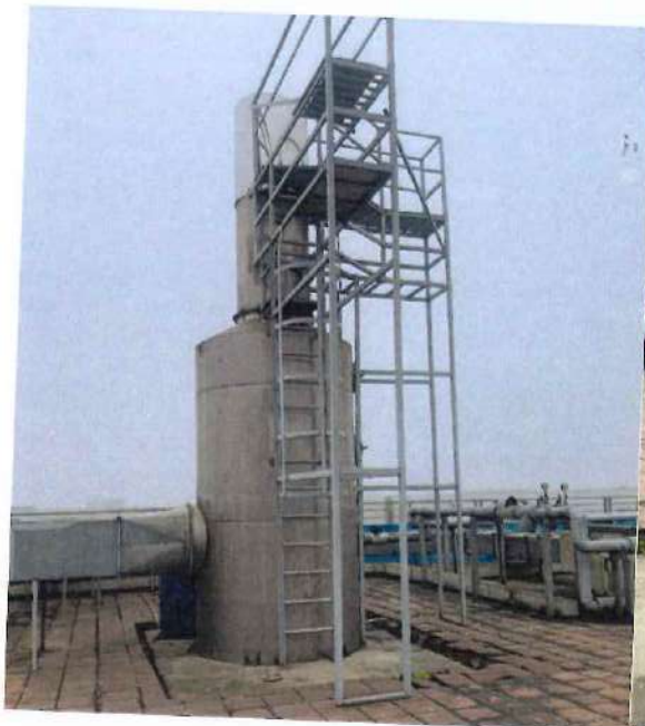
Hình 10 Hệ thống thu gom và xử lý khí thải của khối nhà máy sản xuất số 1
