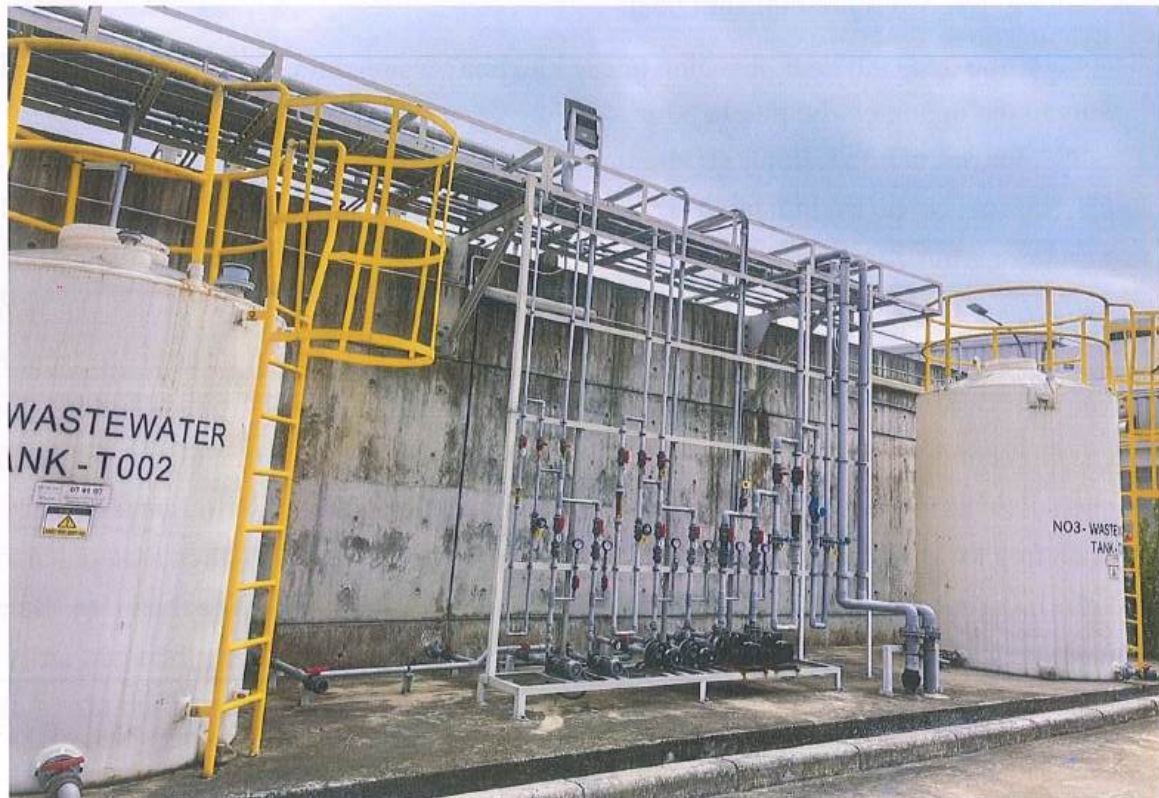
Hình 5: Bồn chứa nước thải nồng độ cao Nitrat (T-003) và Florua (T-002)
