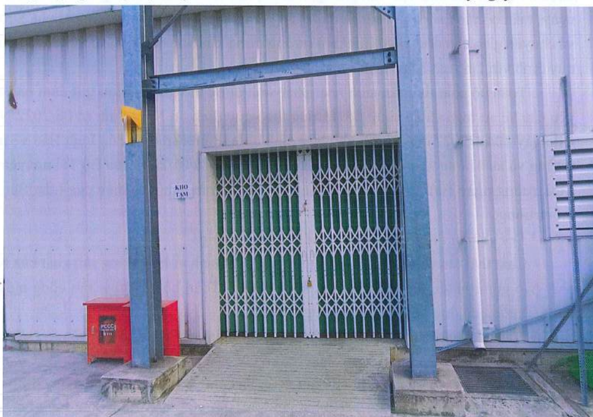
Hình 11: Kho chứa CTNH hiện trạng của nhà máy
