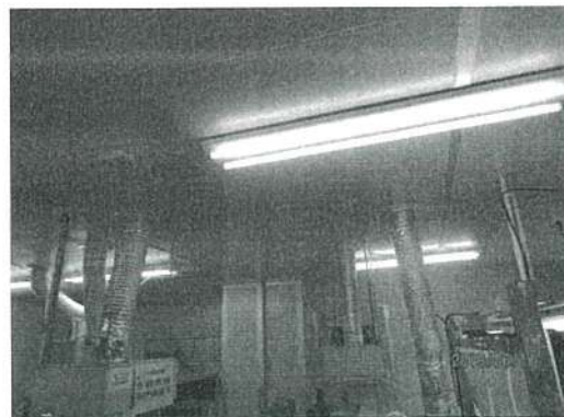
Hình 16. Chụp hút và đường dẫn khí dây chuyền in
