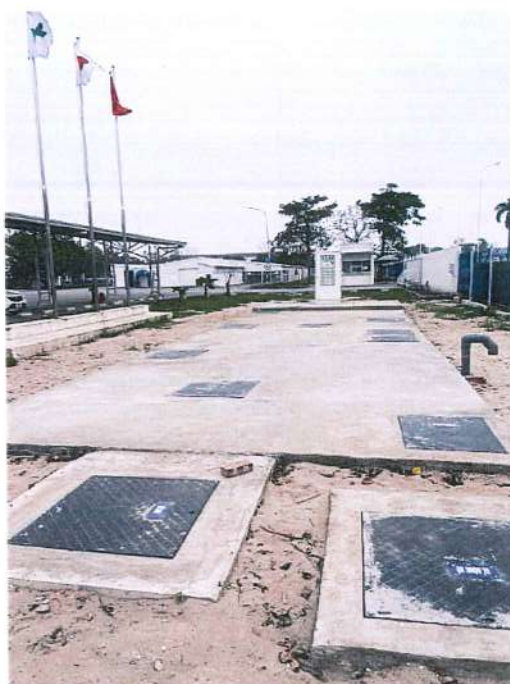
Các bể xử lý nước thải được xây ngầm Tủ điện điều khiển của hệ thống xử lý nước thải
