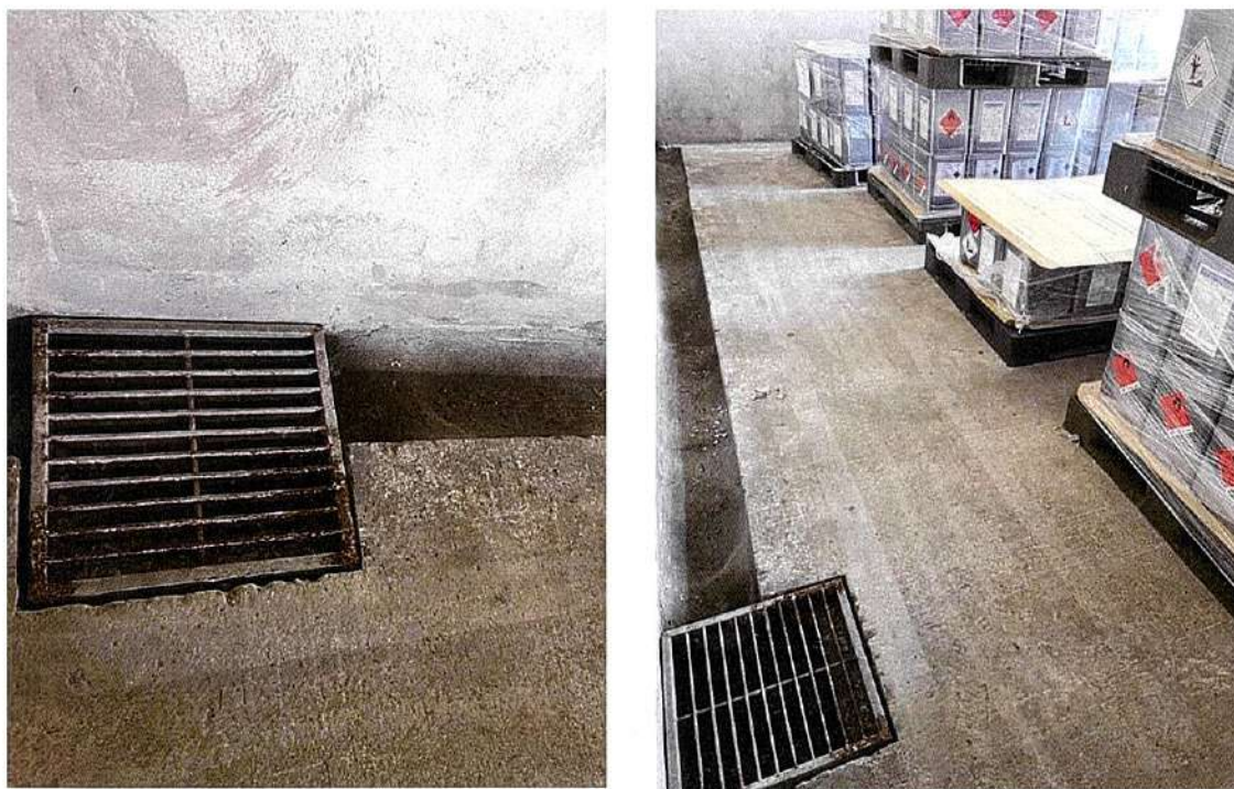
Hình 4: Rãnh thu và hố thu gom hóa chất chảy tràn khi có sự cố tràn đổ
