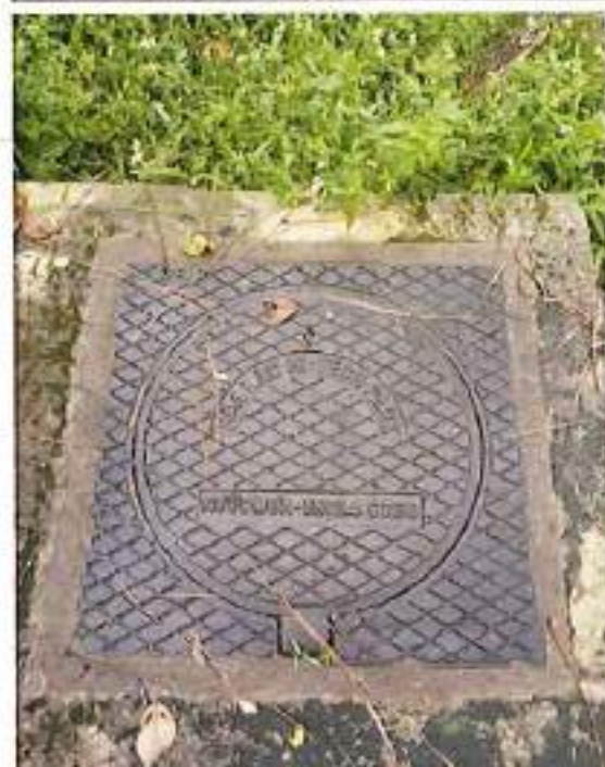
Hố ga đầu nổi nước mưa khu FV2
