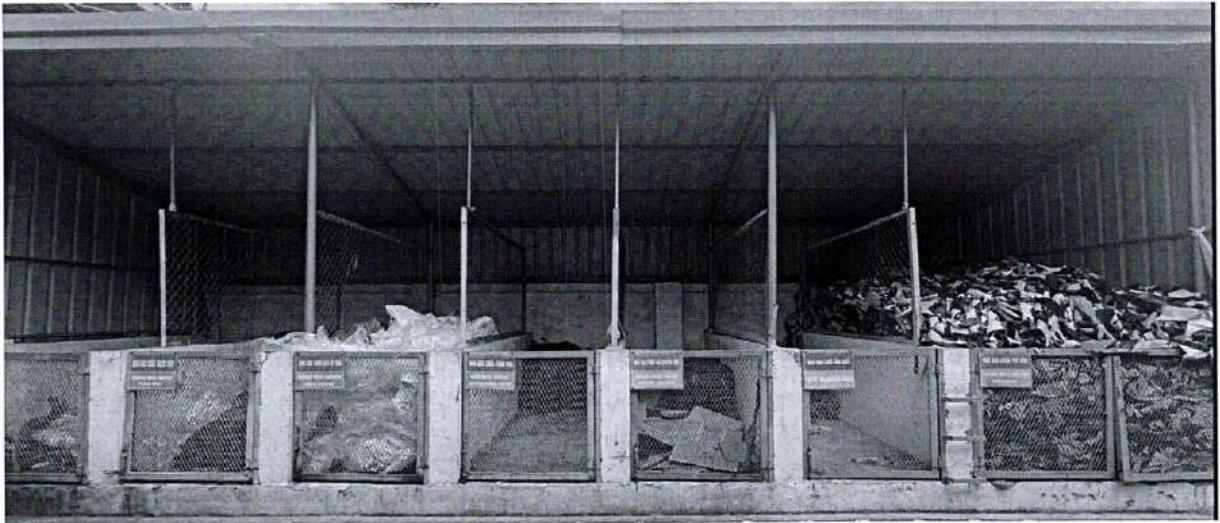
Hình 4. Kho chứa chất thải sinh hoạt và chất thải rắn công nghiệp thông thường của cơ sở
